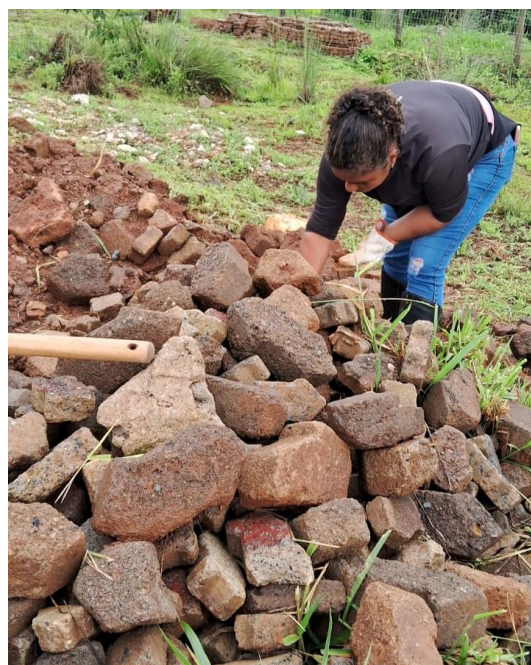
Figura 1: Organização dos blocos de calçamento.
