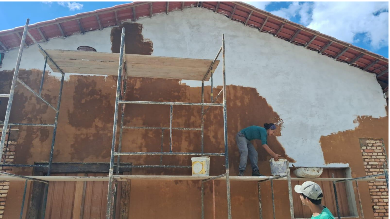
Figura 18: Pintura do Centro Comunitário com tinta de terra.
