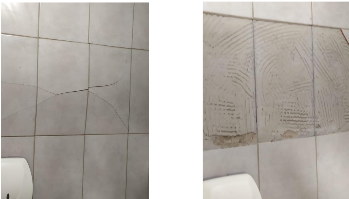
Figura 1: Remoção do revestimento que estava em situação de risco dos banheiros.
