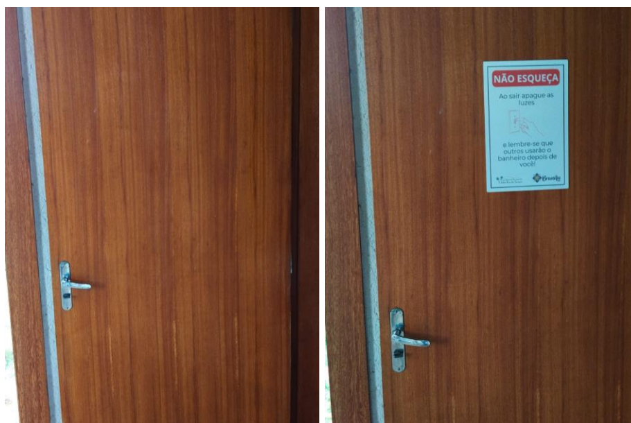
Figura 2: Instalação de placas nas portas dos banheiros no CAT.
