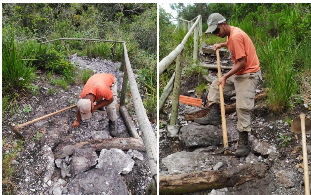
Figura 26: Reparo dos degraus para acessar a última queda da cachoeira dois-córregos.
