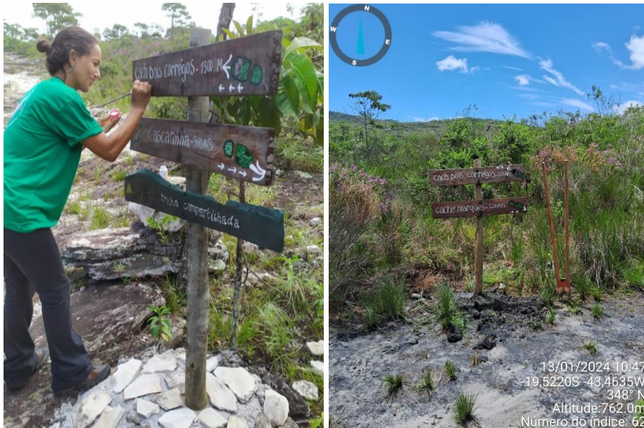
Figura 25: Retoque e reparos em placas de sinalização dos atrativos.
