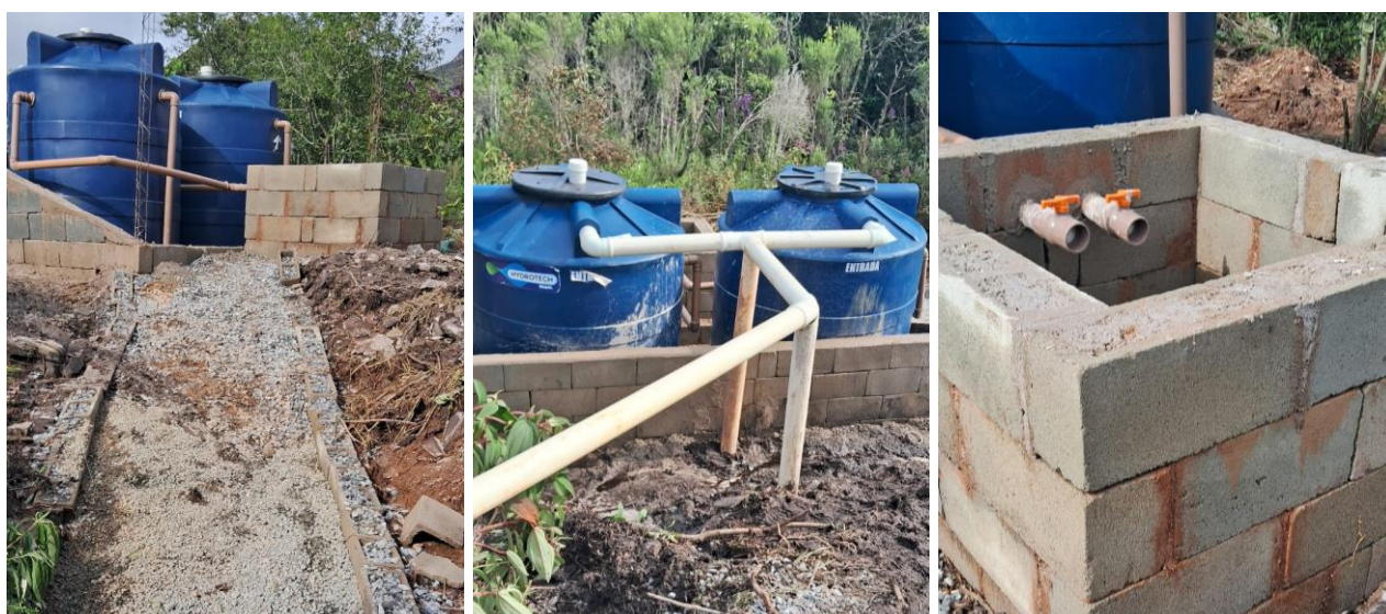
Figura 26: Instalação do biodigestor no CAT.
