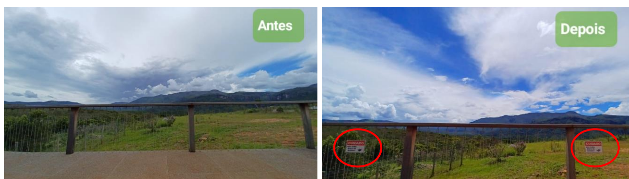
Figura 1: Instalação de placas de advertência para não subir no guarda corpo.
