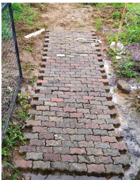
Figura 27: Instalação de blocos no calçamento.
