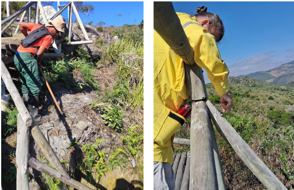
Figura 17: Manutenção da trilha e inspeção das estruturas das escadas e mirantes.
