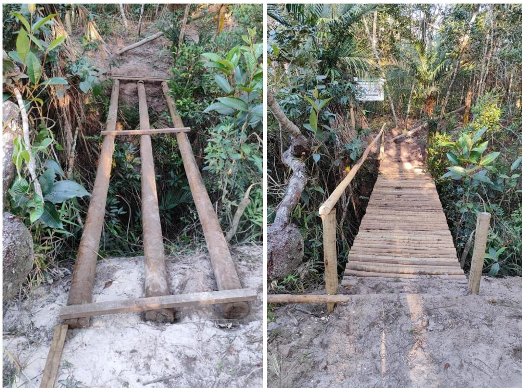
Figura 23: Construção da ponte de acesso à cachoeira dos Marque.
