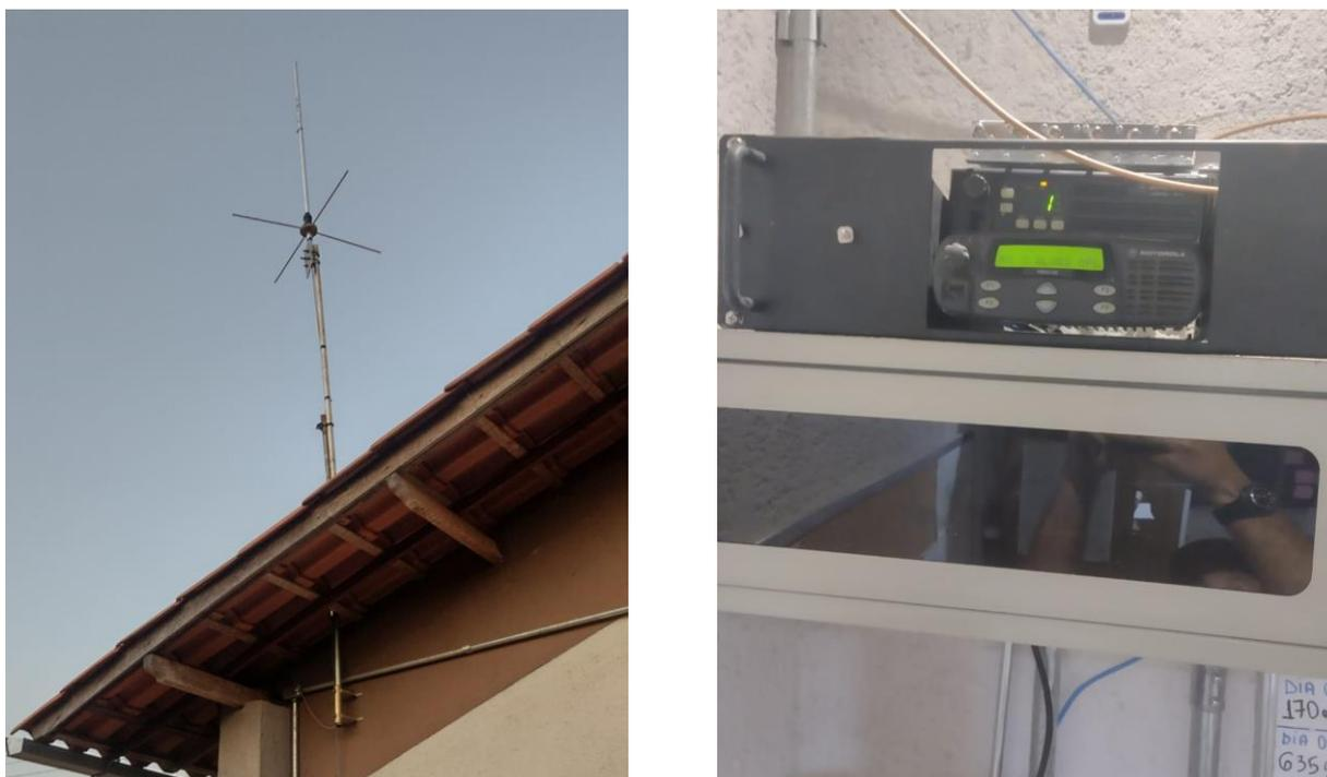
Figura 21: Antena e rádio repetidor instalados no CAT.
