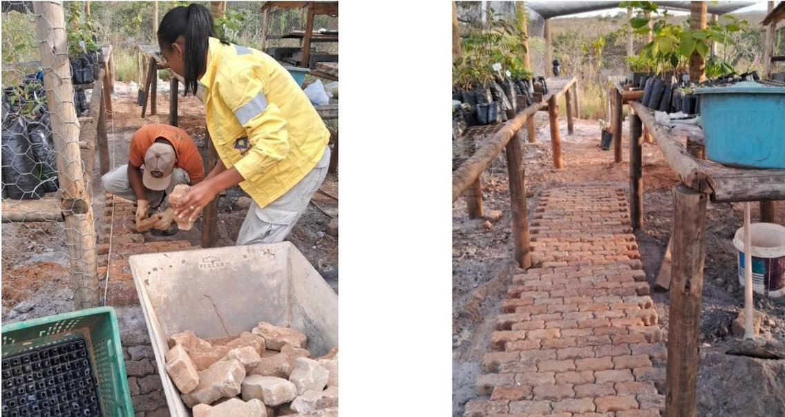
Figura 2: Instalação de blocos no piso do viveiros.
