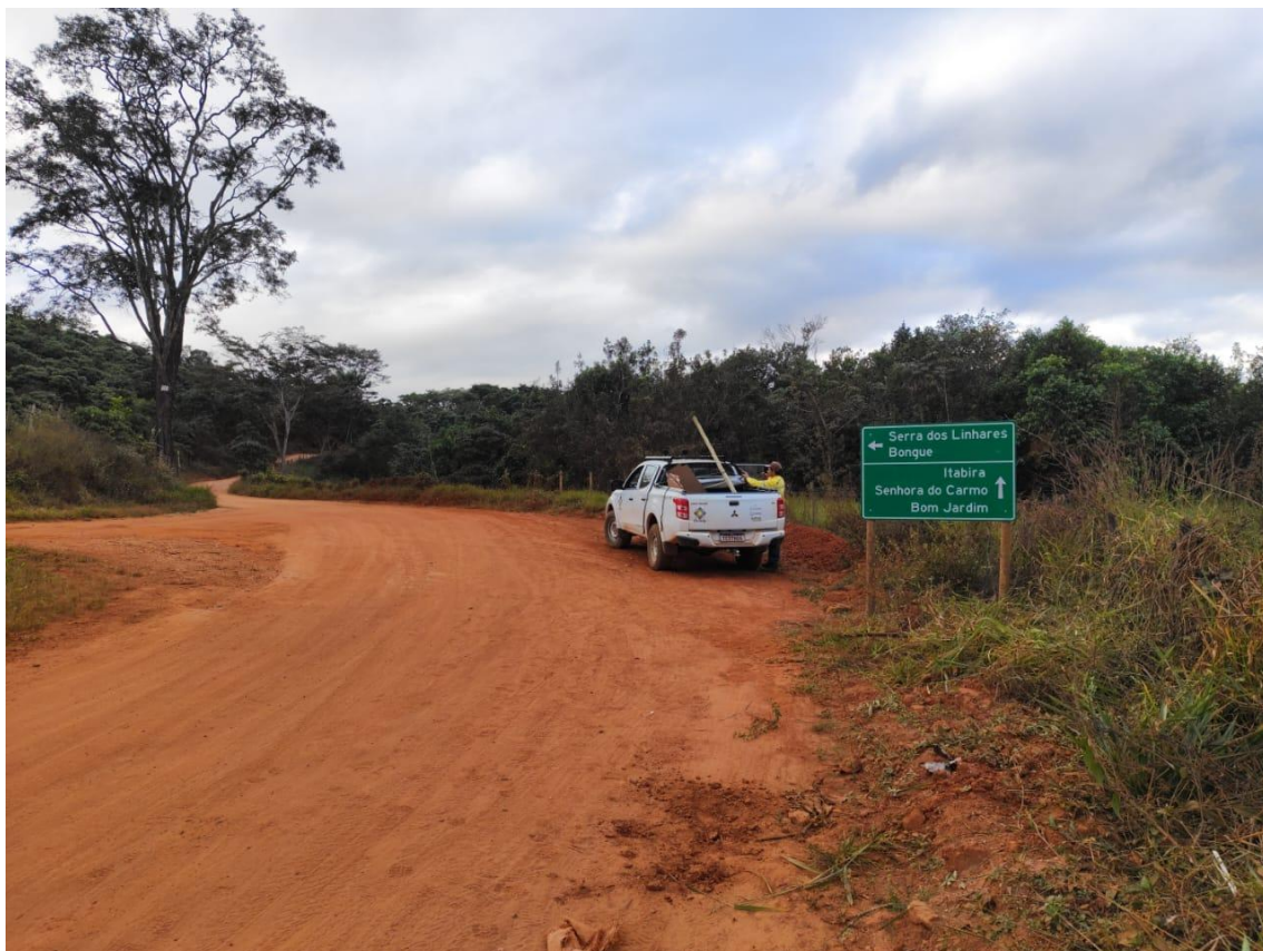
Figura 17: Instalação de placas na estrada entre Serra dos Alves e Senhora do Carmo.
