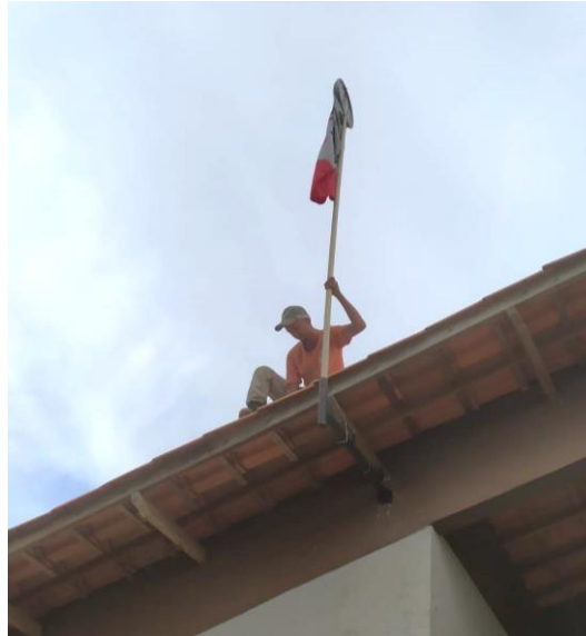
Figura 2: Instalação da biruta no CAT.
