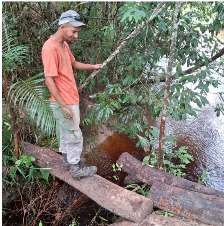
Figura 26: Estrutura da “pinguela” levada pela cheia do rio Tanque.
